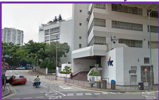
▲ 职业训练局大楼
