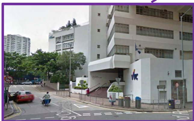
5 职业训练局大楼
